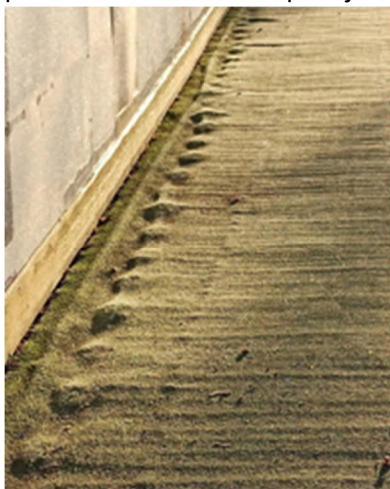
Obr. 1 Potrubí chlazení pod umělou trávou
