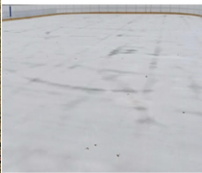
Obr. 2 – Viditelné spoje koberce pod ledovou plochou
